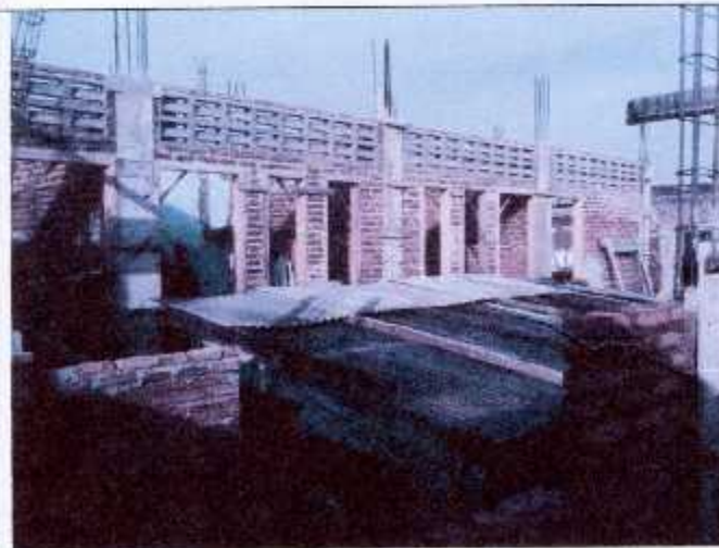
Pemasangan Bata merah di LT II
