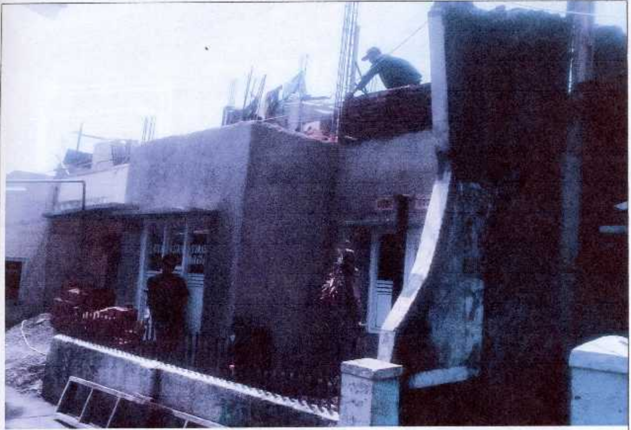
Tampak Bangunan Depan
