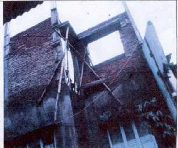
Pemasangan Beton di LTII sisi Kiri
